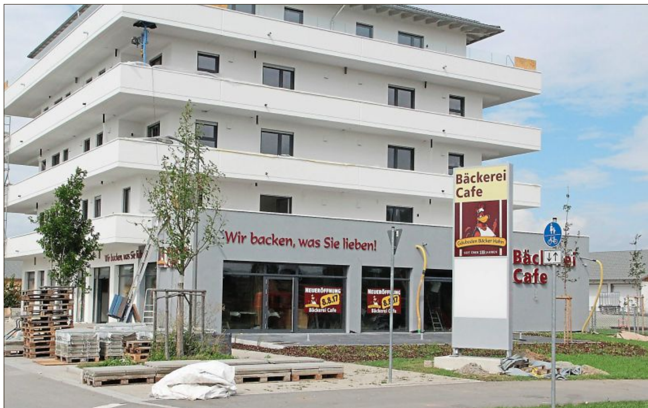
Bis zur Eröffnung der 50. Filiale der Gäubodenbäckerei Hahn am kommenden Dienstag ist von der Baustelle nichts mehr zu sehen.
