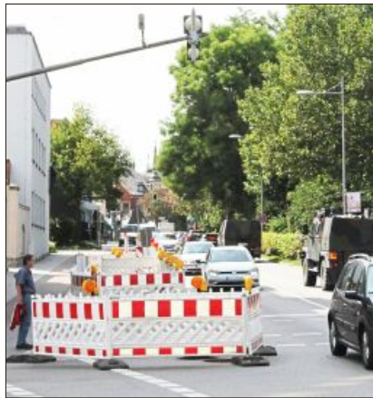
Am Stadtgraben: Die gefühlte erste Baustelle nach dem Volksfest.
